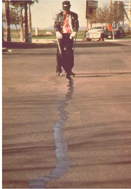
Figure 4.9 Use of Pour Pot to Seal Cracks
